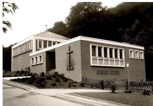
Außenansicht der Kirche nach der Fertigstellung
